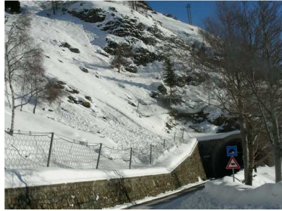
Fig. 02: primo impatto → valanga su barriera, altezza della neve sulla struttura H \approx 1,00 \text{ m} (foto 15/01/14).
