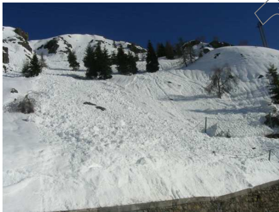
Fig. 03: secondo impatto → valanga su barriera, altezza della neve sulla struttura H \approx 3,00 \text{ m} (foto 06/03/14).
